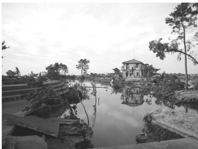
宮城県多賀城市七ヶ浜町沿岸部 一部水没した住宅地 (2011/3/24)
